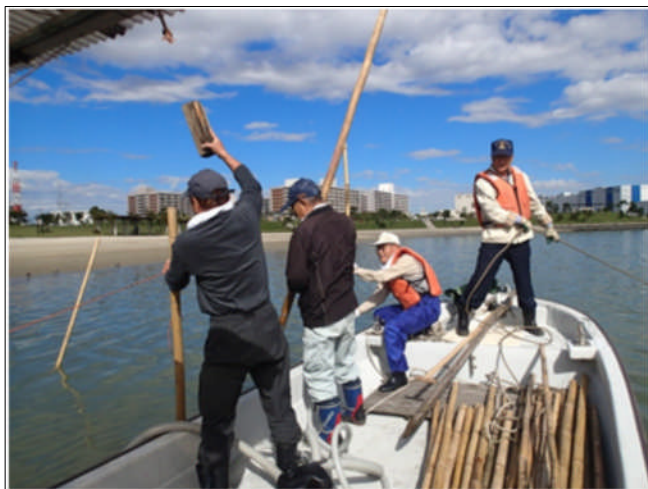
10/17 支柱建て作業
